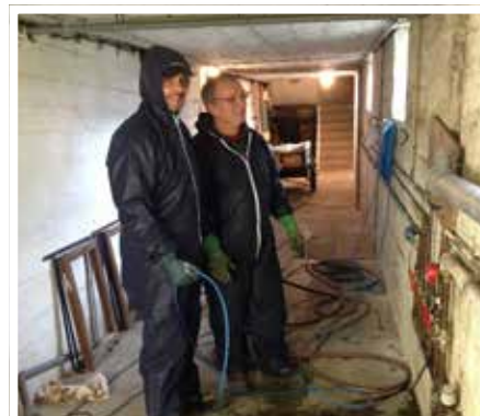
travaux renouvellement des conduites à l'école
